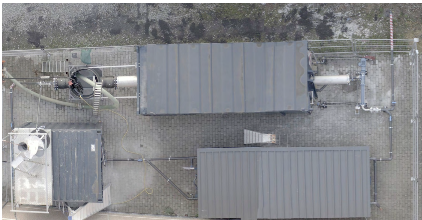
Figure 1 – Photo aérienne du poste d'essai, installé le long du bâtiment du CRR à Wavre
