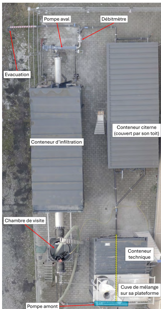
Figure 1 – Photo aérienne annotée du poste d'essai, installé le long du bâtiment du CRR à Wavre.
