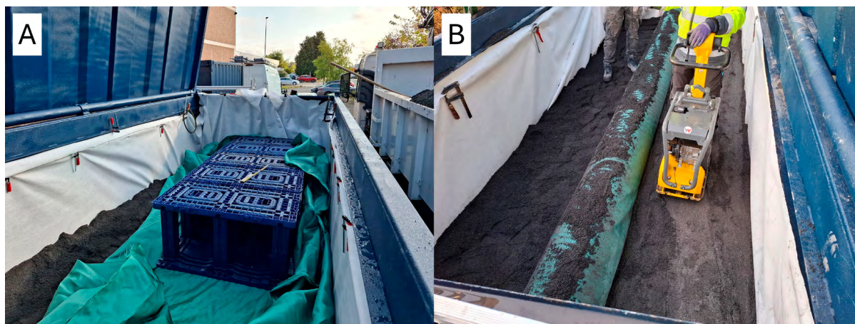
Figure 2 – Installation des deux premiers systèmes d'infiltration dans le poste d'essai.
