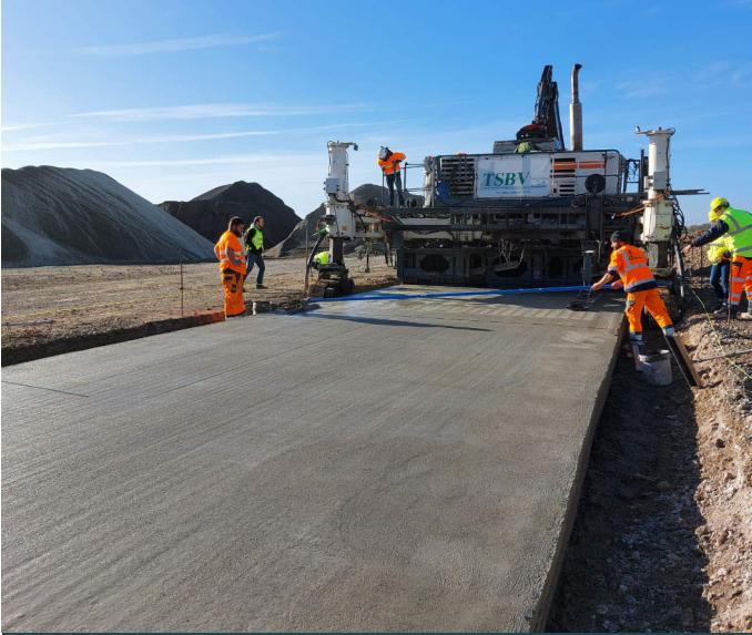
Figuur 2 – Proefvak van het Monocrete-project in Bierset
