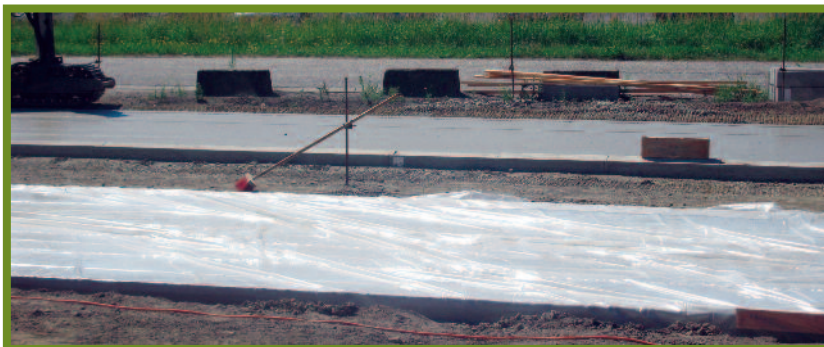
Figuur 8 – Proefvak van tweelaags beton met TiO 2 in de toplaag op het industrieterrein "Den Hoek 3" in Wijnegem
