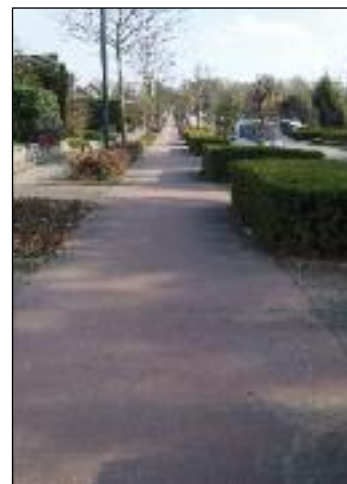
Vrijliggend fietspad met een gekleurde betonverharding
