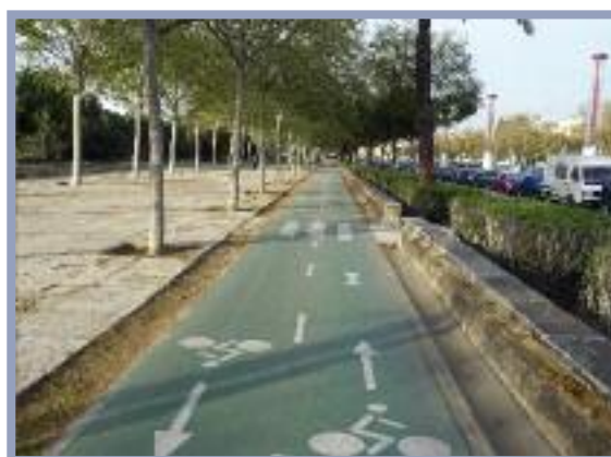
Piste cyclable bidirectionnelle séparée. A noter qu'initialement, la voirie s'étendait jusqu'à l'alignement d'arbres situé à gauche (redistribution de l'espace en faveur du vélo).
