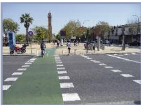
Traversées cyclable et piétonne placées conjointement. A noter la présence d'un feu piéton avec décompte du temps restant et logo piéton animé. Une station Sevici de vélo en libre service est également visible à l'arrière plan.
