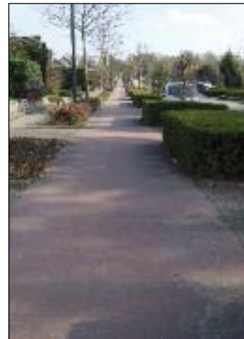
Piste cyclable en béton coloré, séparée de la chaussée
