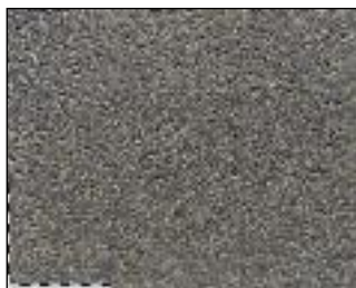
Béton bitumineux BB-1B
