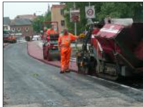
Mise en œuvre
