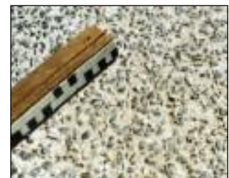
Résultat typique d'un dénudage
