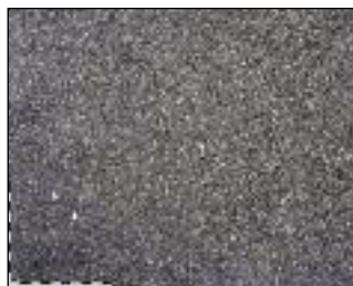
Béton bitumineux BB-4C
