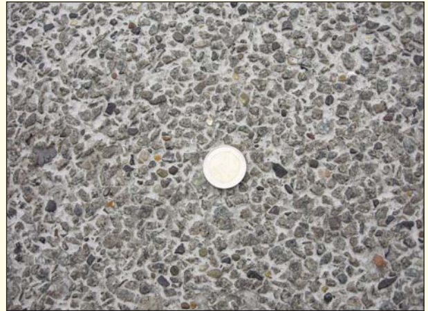
Macrotexture fine de la couche de roulement en béton fin bicouche (non poreux) (N49 à Beveren)
