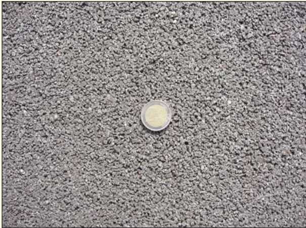
Les pierres de petite taille, entre 2 et 4 mm, de la couche de roulement en béton bitumineux drainant (ZOAB) bicouche procurent une macrotexture fine optimale. Ce type de revêtement est également poreux, ce qui rend la macrotexture fine «superflue». (section expérimentale DUW, Kloosterzande, Zélande, Pays-Bas)
